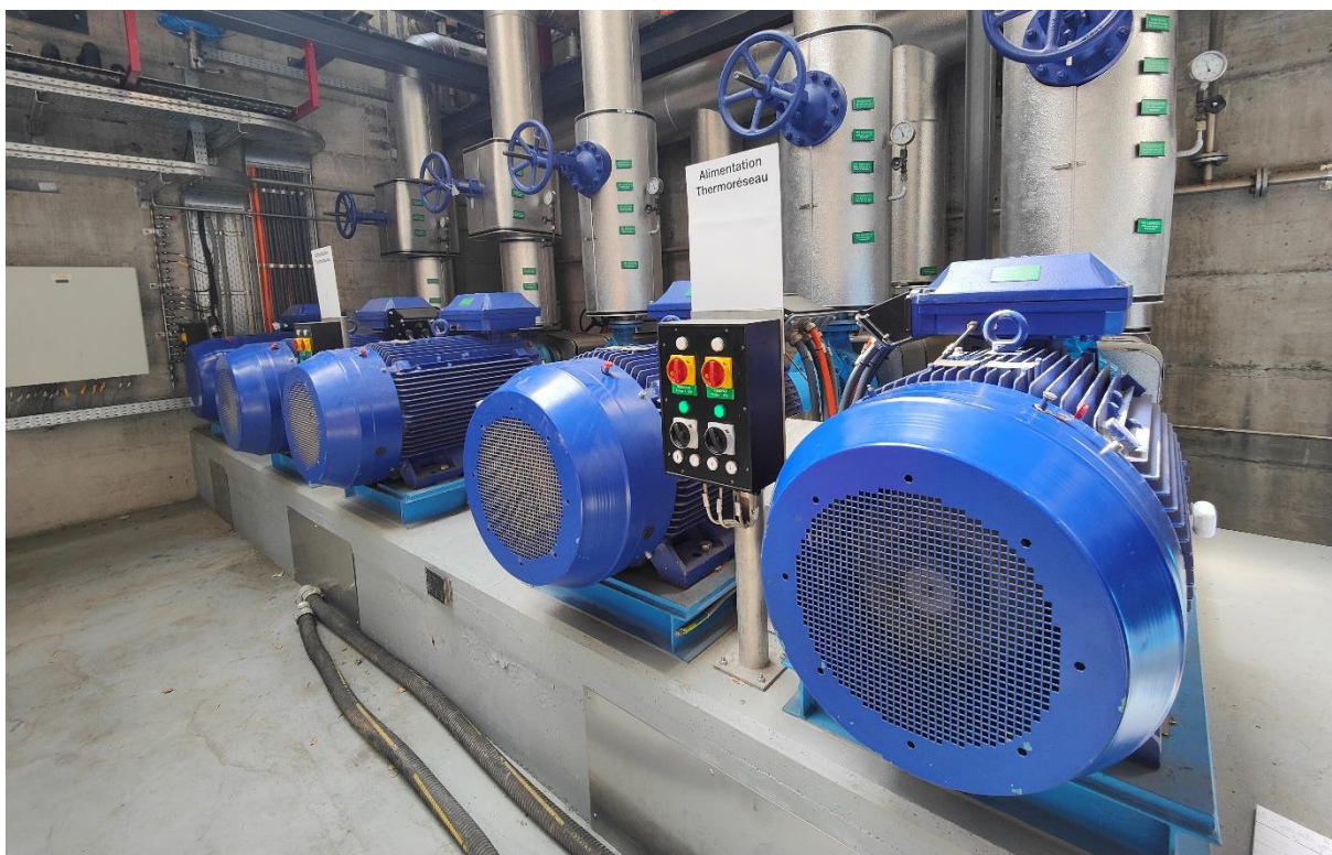
Figure 41 : Pompes actuelles pour la distribution dans le CAD
